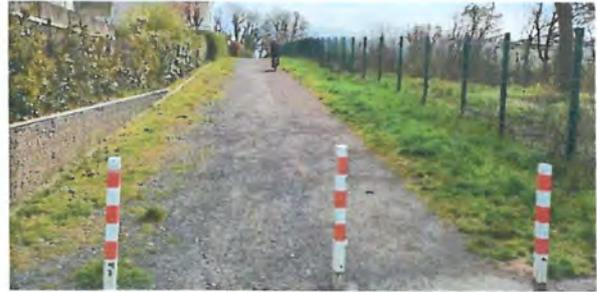
*Foto 12: Jenseits der S-Bahn-Station führt die Route über diesen bahnparallelen Weg weiter, die Poller sind zu entfernen und der Weg möglichst zu befestigen.*
