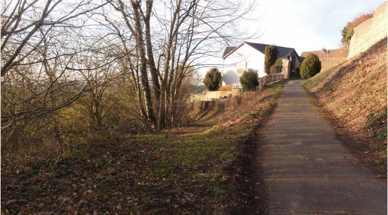
Abb. 4: Ausbau des Wiesenwegs zu einem barrierefreien Fußweg in wassergebundener Bauweise
