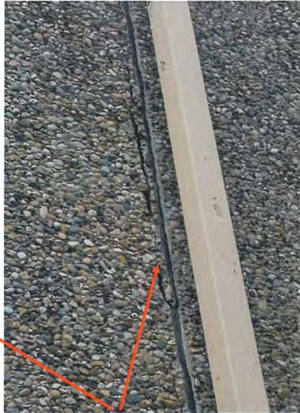
Erkennbare Betonabplatzungen, Eintritt von Wasser und Frost möglich. Zudem poröse Fugen
