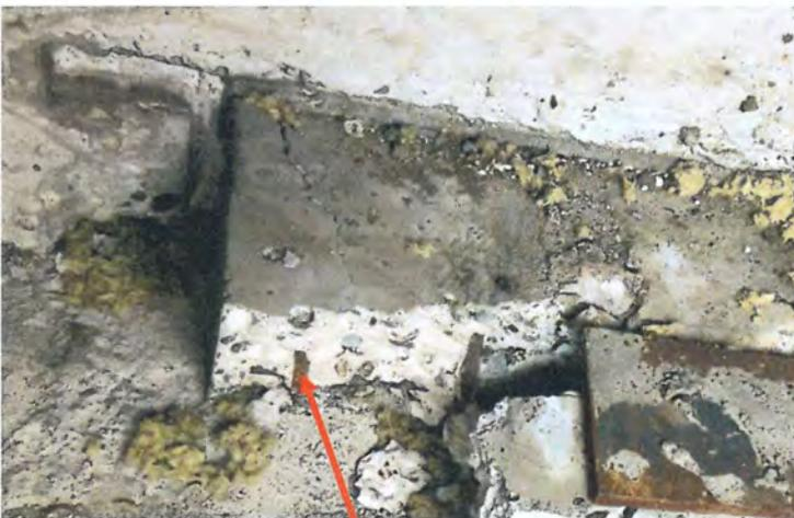
Korrosion der Bewehrung. Dadurch platzt mehr und mehr der Beton ab.
