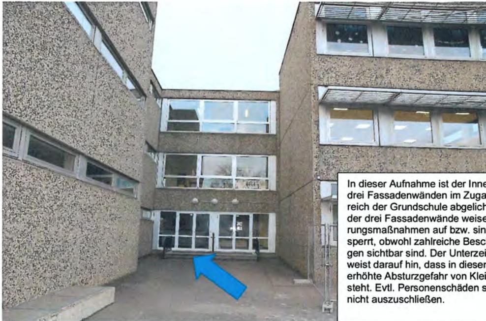
In dieser Aufnahme ist der Innenhof mit drei Fassadenwänden im Zugangsbereich der Grundschule abgelichtet. Keiner der drei Fassadenwände weisen Sicherungsmaßnahmen auf bzw. sind abgesperrt, obwohl zahlreiche Beschädigungen sichtbar sind. Der Unterzeichner weist darauf hin, dass in diesem Bereich erhöhte Absturzgefahr von Kleinteilen besteht. Evtl. Personenschäden sind daher nicht auszuschließen.
