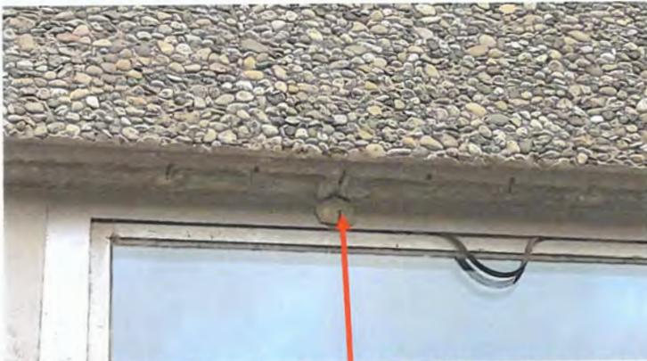
Allseits freigelegte Bewehrungen, dadurch Korrosion und Betonabplatzungen
