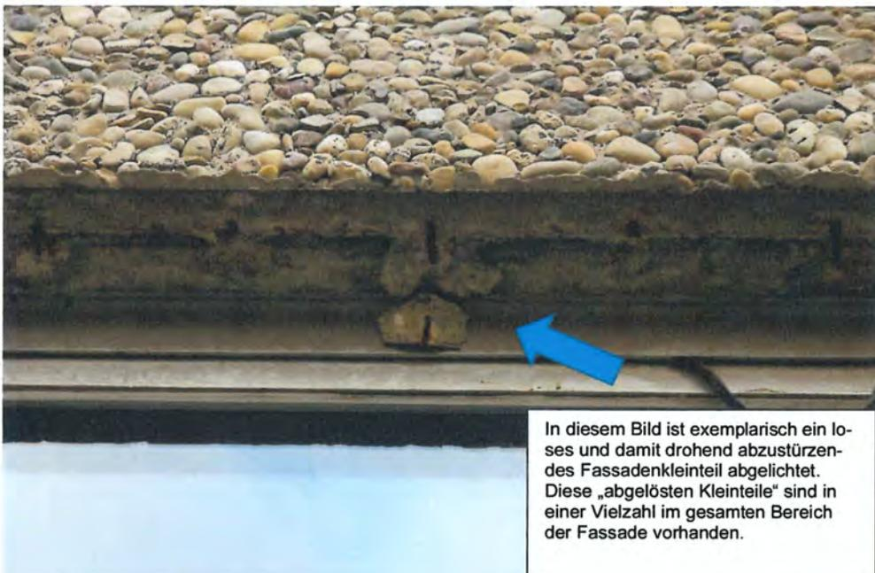
In diesem Bild ist exemplarisch ein loses und damit drohend abzustürzendes Fassadenkleinteil abgelichtet. Diese „abgelösten Kleinteile“ sind in einer Vielzahl im gesamten Bereich der Fassade vorhanden.
