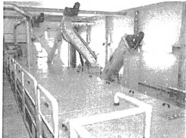
Sauberer Rechengut- und Sandfanggutaustrag bei der ROTAMAT® Kompaktanlage Ro 5
